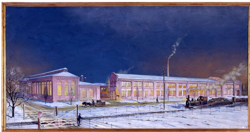
Figur 33. Eureka Mek. Verksted 1907, malt av Jens Wang til Jubileumsutstillingen på Frogner 1914. Foto Norsk Teknisk Museum.
