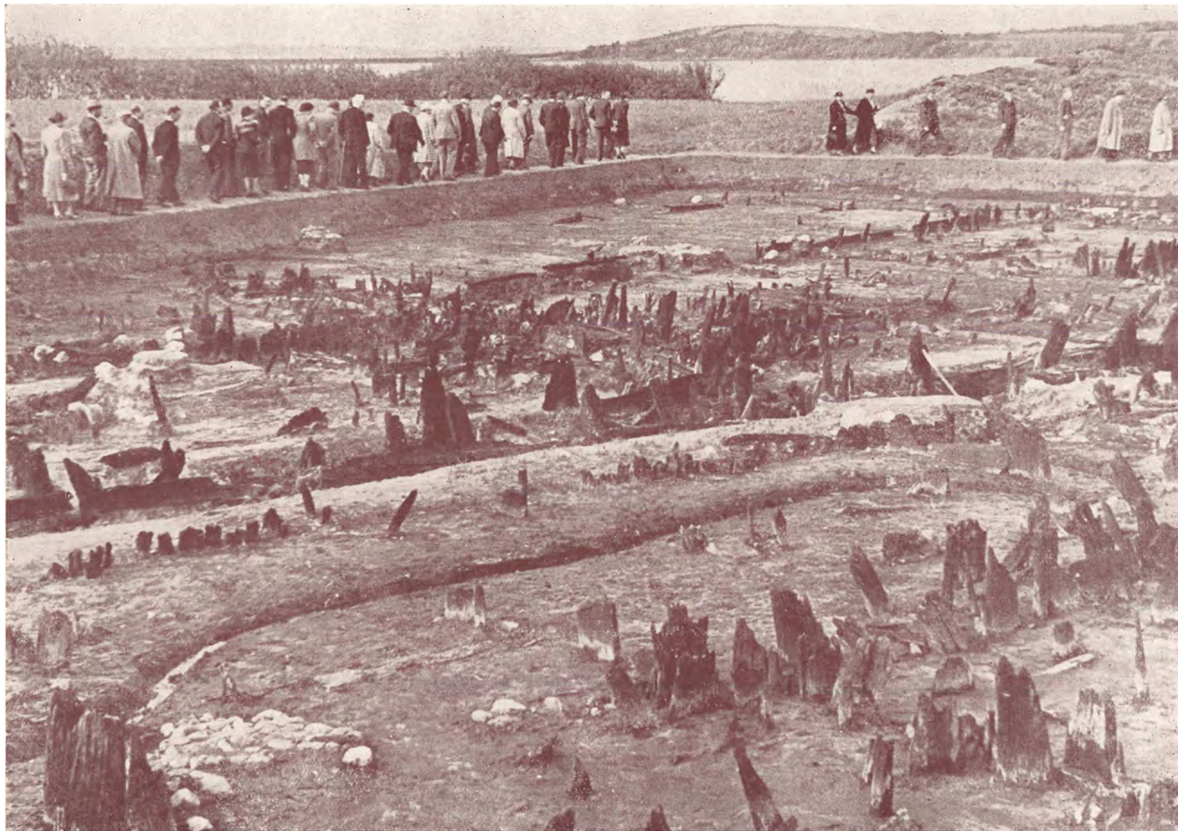
Fig. 14. Hedeby. I Forgrunden Plankevæggene fra et Hus. I Midten Bolværket ved Bækken. Udgravningen besøges af et dansk Selskab. I Baggrunden Noret. (Kamphøener fot.).
