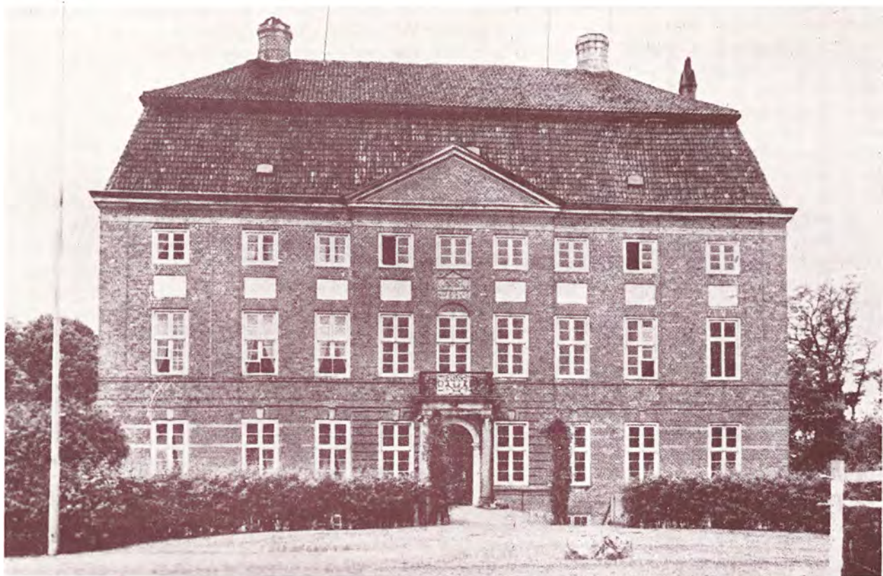
Herregaarden Kohøved (siden 1768 kaldet Ludwigsburg) i Svansø. Bygget ca. 1740.
