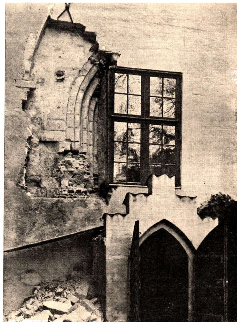
Fig. 18. Vindue i søndre Korsarms Østmur.
