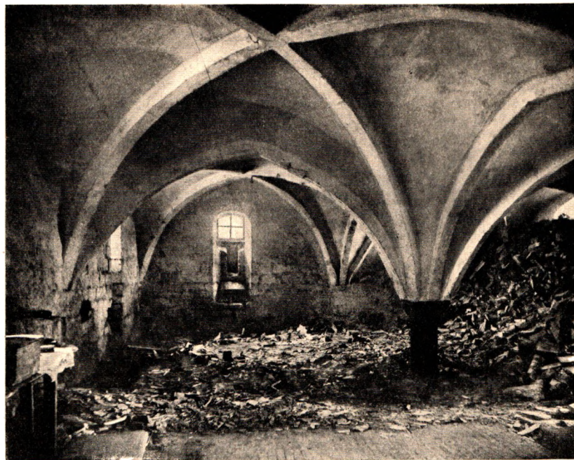
Fig. 5. Nordre Korsarms Kælder.
