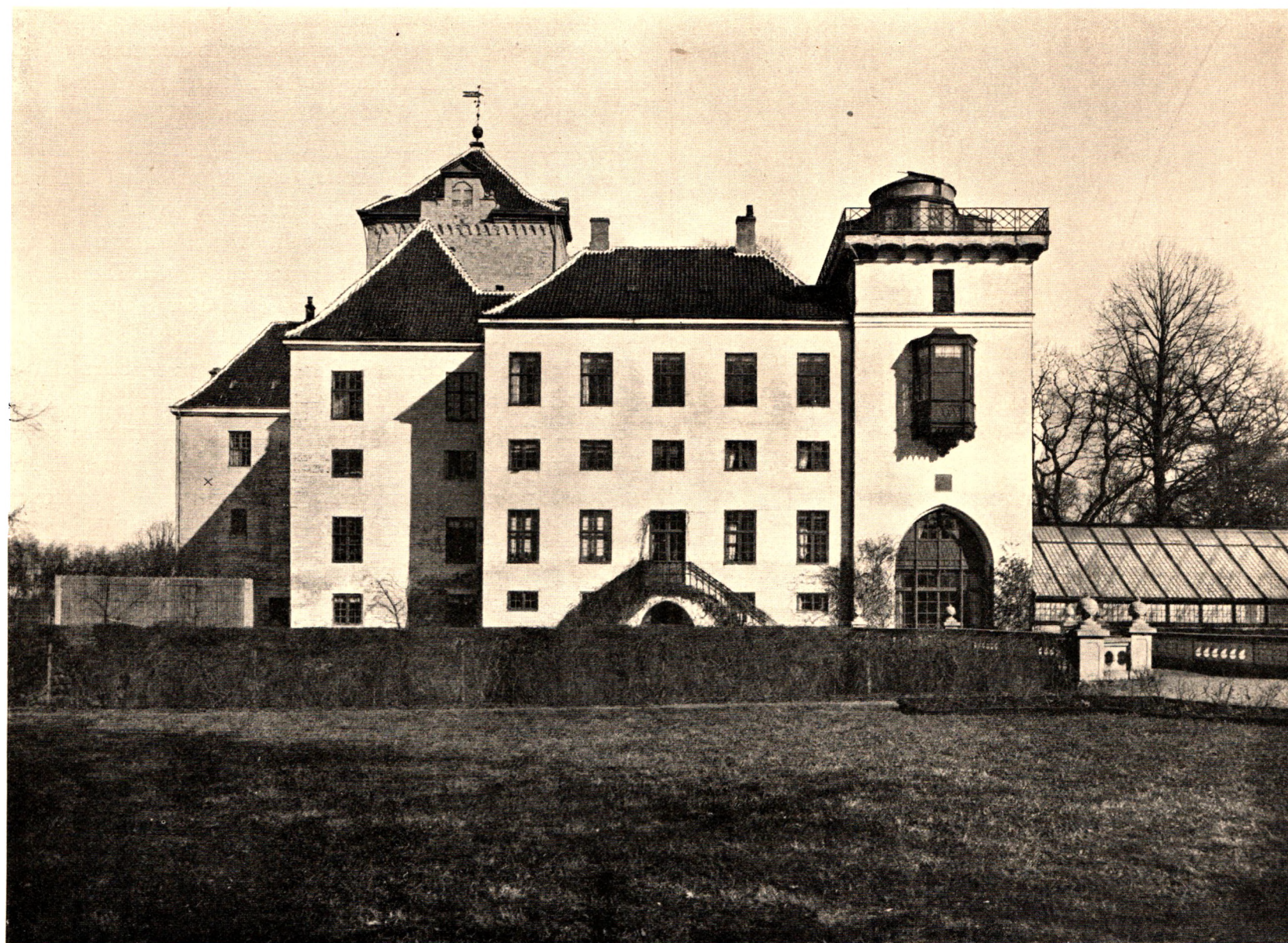
Fig. 31. Bygningen set fra Syd.
