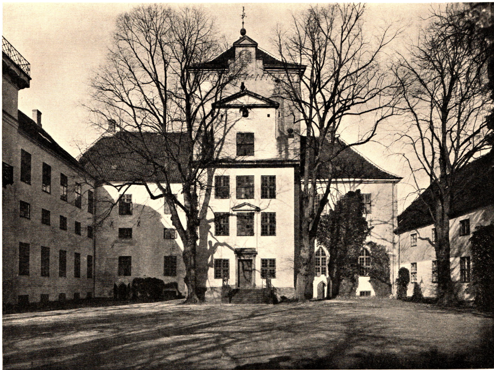
Fig. 27. Bygningen set fra Øst.
