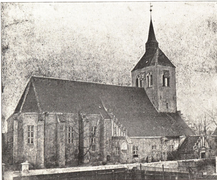
Kirken, set fra Kirkestræde, under Nedbrydningen.
