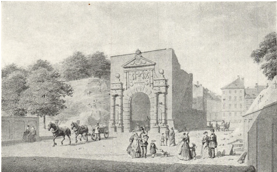
Vesterports nedrivning 1857. Tegning, H. G. F. Holm. Københavns Bymuseum.
