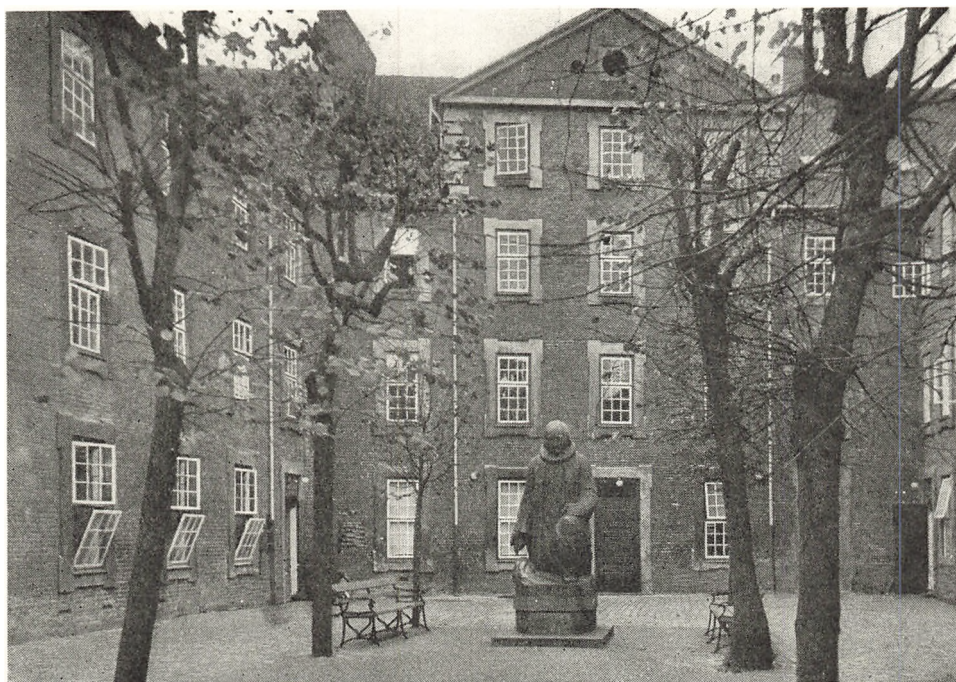
Interior fra Vartovs gård set mod Vestervoldgadefløjen.
