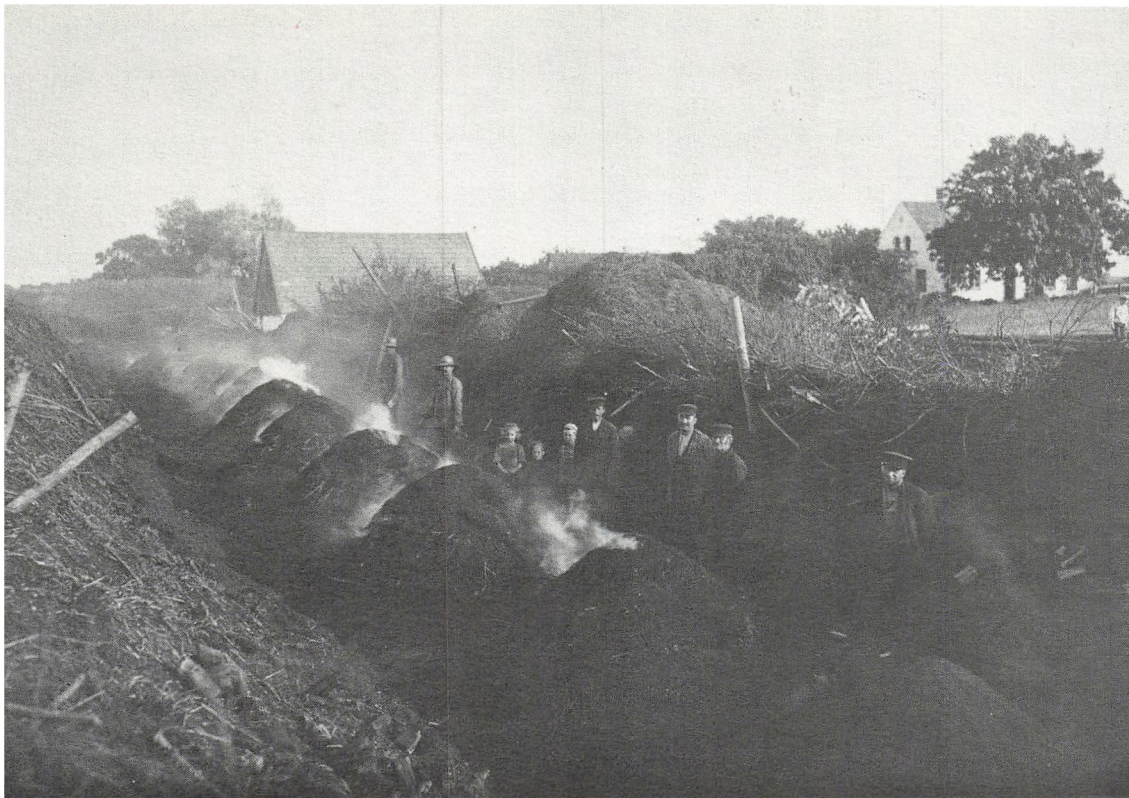
■ Milerne er dækket med kulster. Fra højre ses Hans Peter Henriksen, og Hans Henriksen som nr. 3. Ved siden af står Jens Pedersen med sine børn. I baggrunden ses det oprindelige hus til venstre, og til højre ses huset, der blev bygget omkring 1900. Fotografi fra 1930'rne. (Hillerød Bibliotek)
