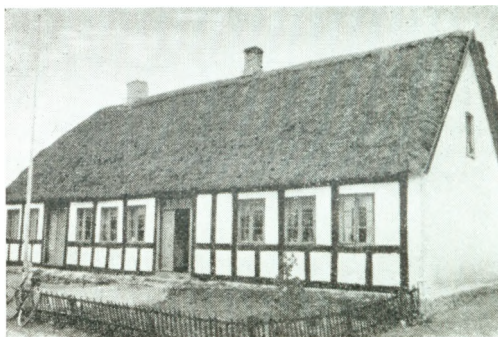
Skjæring gamle Skole.
