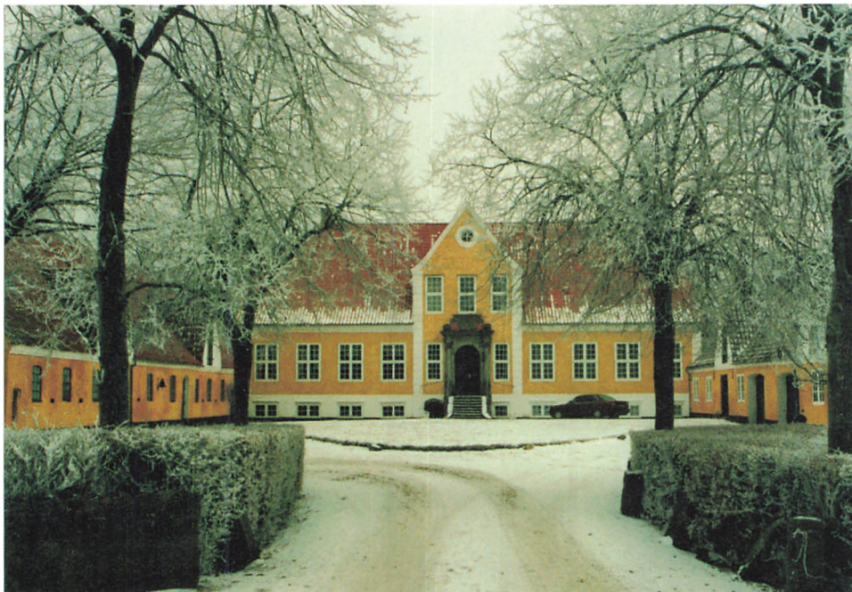
Hovedbygningen til Skovbølgård 1997.
