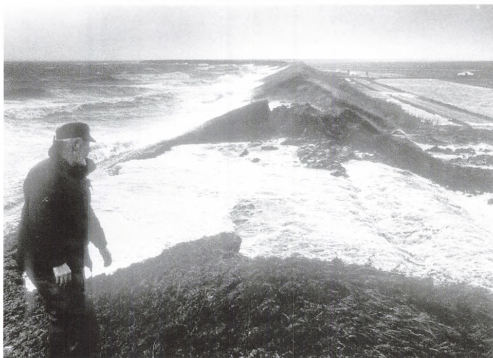
Et digebrud 3. januar 1976 på en tid, hvor Staten bidrog til at reparere hullerne.
