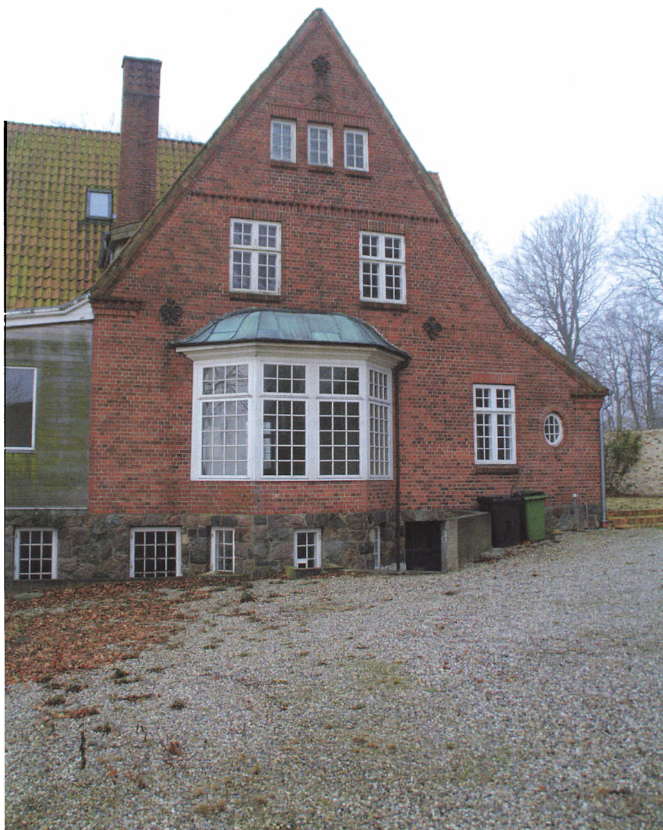
Aabenraa Kommune har givet tilladelse til nedrivning af Fjordvej 98 i Holbøl, der er opført 1907 i Heimatschutz-stil. Bygningen er formentlig tegnet af en flensborg-arkitekt.
