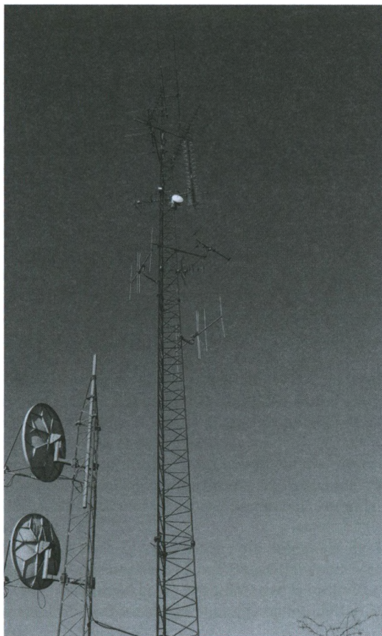
Fællesantenneforeningens antennemaster, der står i gården ved Eriksminde-Centret.
