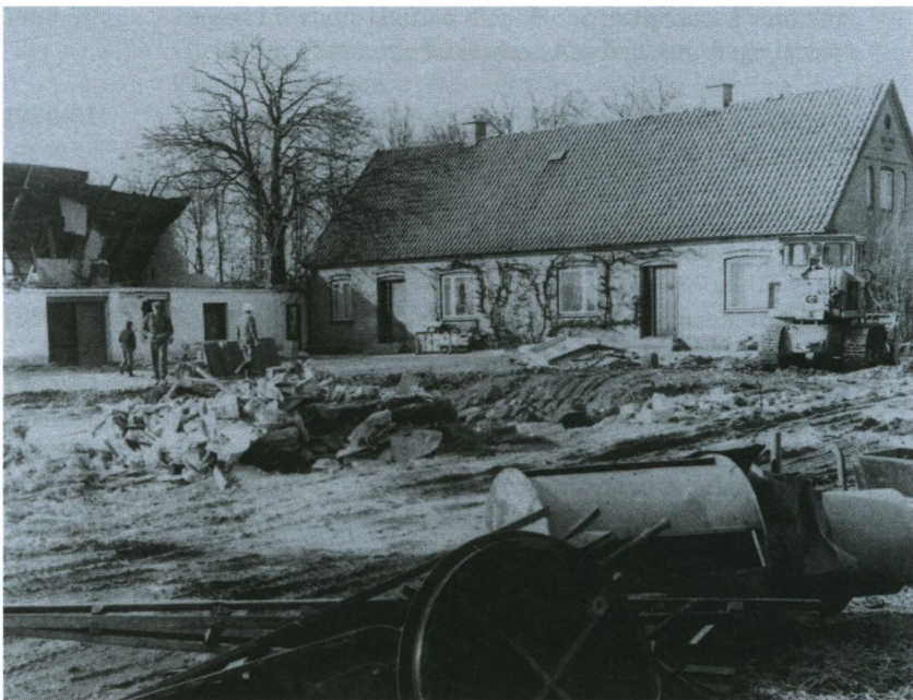
Eriksmindegårdens avlsbygninger under nedrivning 1968. Stuehuset er dog bevaret som bolig.
