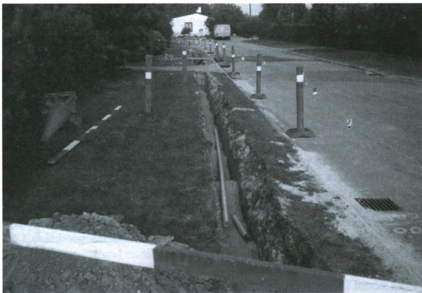
Nedlægning af naturgasledning i sommeren 1984.
