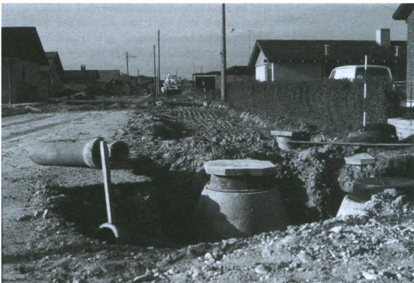
Kloakering på Højager.
