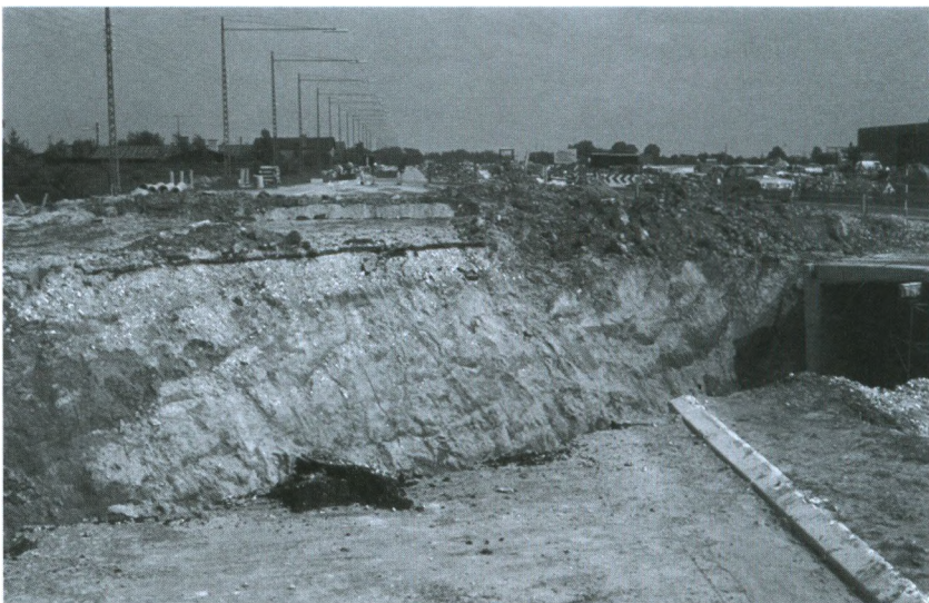
Udgravning til tunnel under Godsvej fra Højager til Hundige Storcenter. Under udførelsen af dette arbejde var vejen afspærret.
