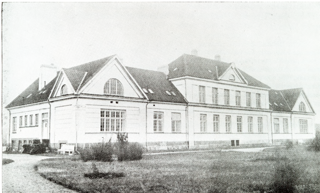
Frederikshavns kommunale Sygehus, set fra Syd
