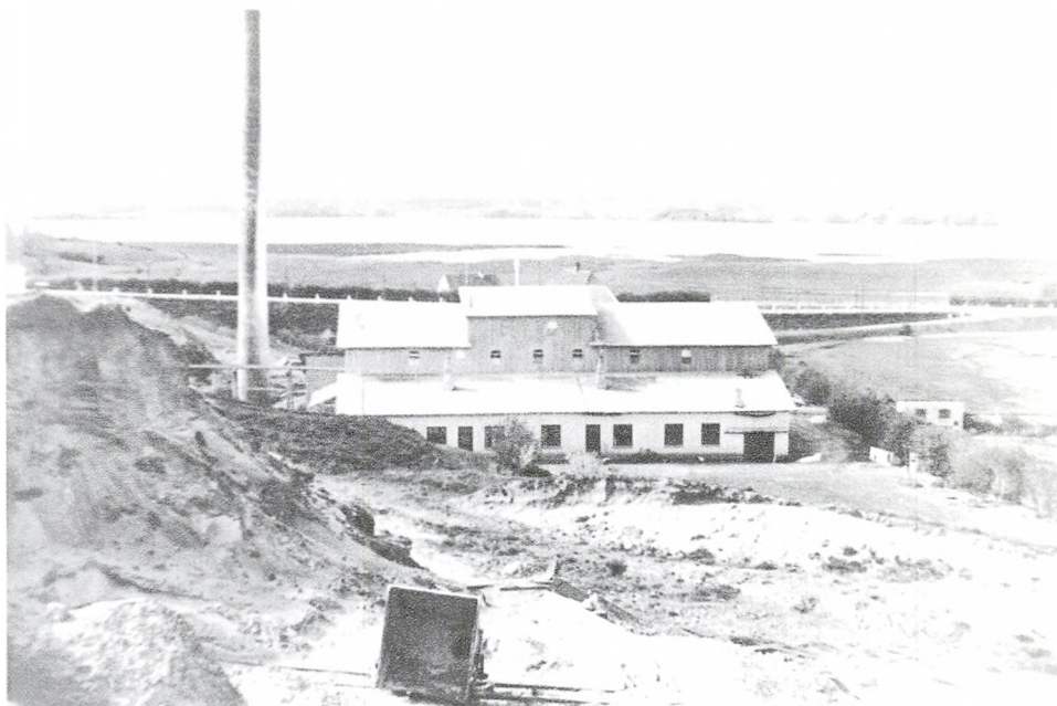
Fabrikken set fra syd. Til venstre ses sandbakken, hvor sandet blev hentet i tipvogne, der kørte ned til fabrikken.
