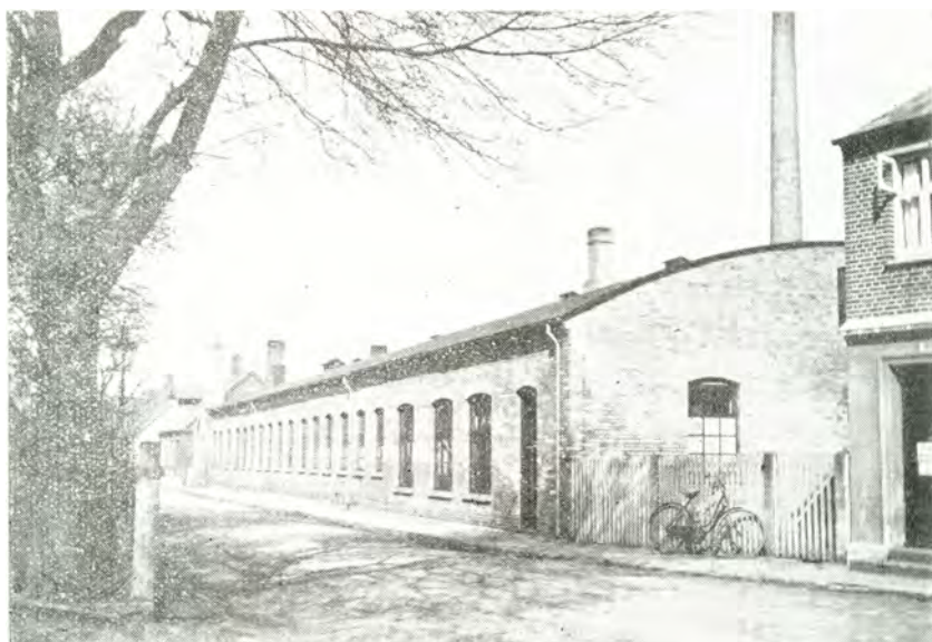
J. Petersens Beslagfabrik.
