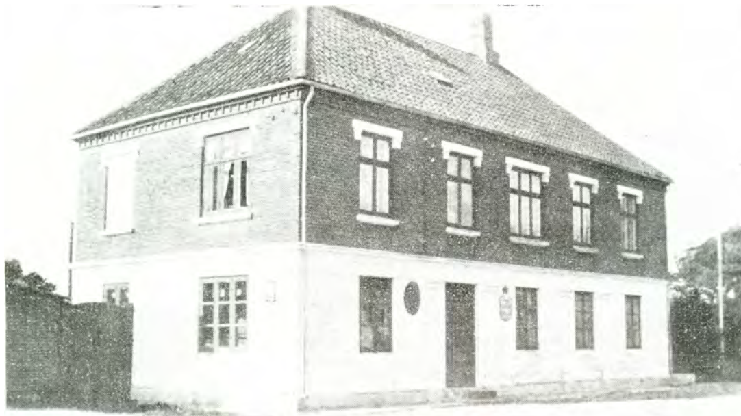
Toldbygningen i Nibe.
