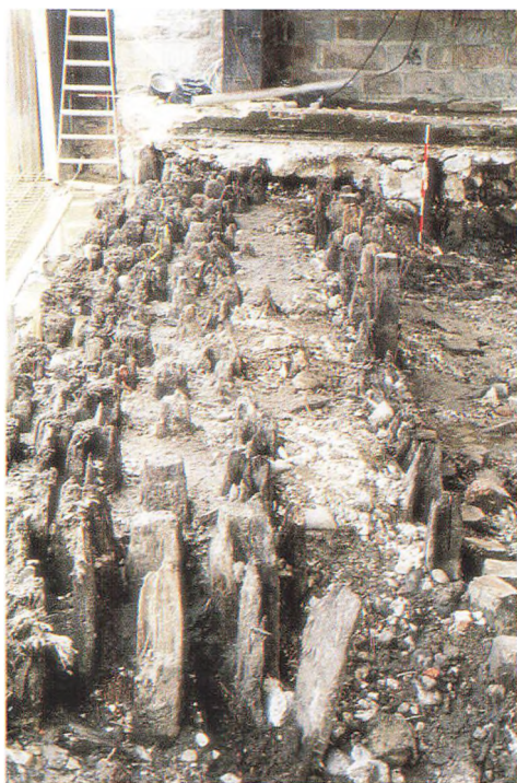
De fem rækker stemmeværker set fra nord. Søen ligger til venstre i billedet. Det forreste stemmeværk er fra ca. 1700. Dernæst følger to tætstående stemmeværker fra ca. 1600, og ét (midt i billedet) fra ca. 1545. Stemmeværket længst til højre er det ikke lykkedes at datere, men det stammer sandsynligvis fra 1587, idet en stolpe, der sandsynligvis har forbindelse hermed, er fældet vinteren 1586/87. Foto: Lennart S. Madsen/Haderslev Museum.
