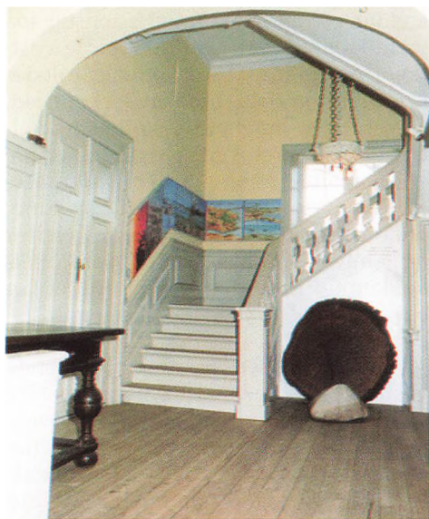
Ved den store istandsættelse af slottet 1906 – 10 blev hovedtrappen i vestfløjen fornyet i en noget bastant barokstil. Arkitekten Gotfred Tvede var særdeles dygtig til at tilpasse nye bygningsdele, så det er vanskeligt at kende forskel på originale og fornyede bygningsdetaljer. Foto: Martin Abrahamsson.
