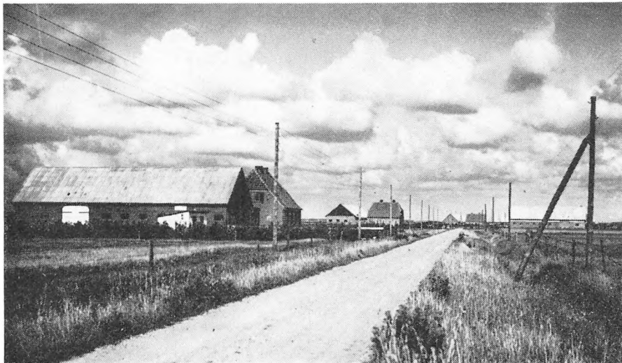
Geesten. »Den færdigbyggede landsby« Bjerndrup nord for Løgumkloster opførtes i årene 1930–35 og består af ca. 34 nye landbrug. Der blev gennemført en hovedafvanding, og der blev anlagt et helt nyt vejnet.
