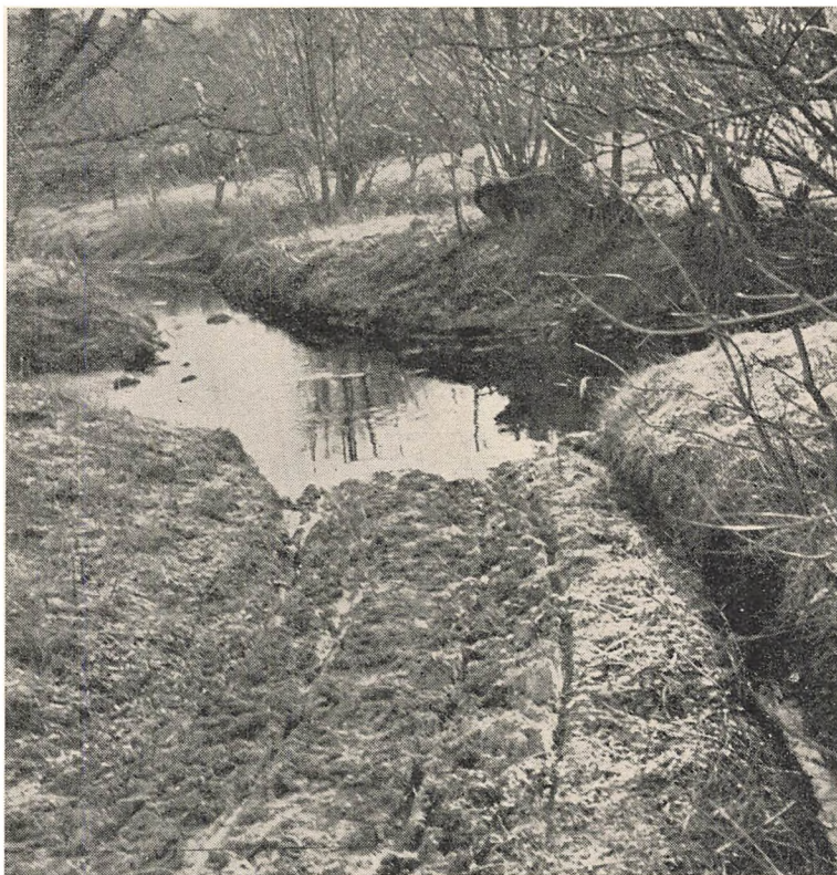
Overkørsel til Pejthaven gennem den tvedelte Aa.
