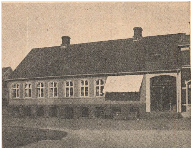
Fabrikens Forbygning Adelgade 94 i 1890'erne.
