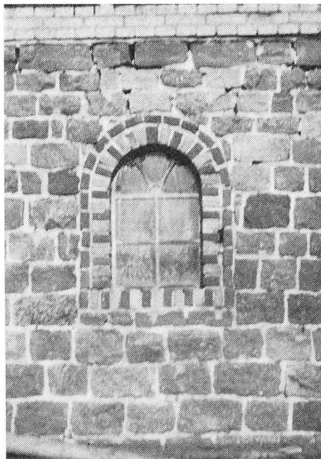
Vindue i Hummelballegårds lade. Muren har taget skade ved branden 1933 og er afstilvet med jernbjælker.
