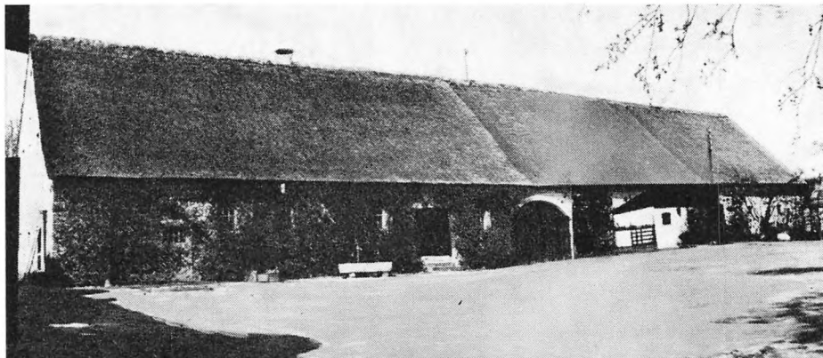
»Kæmpeladen« på Vorsø. Den er oprindelig bygget som stald til fedestude. Laden er ca. 50 meter lang og muren 3,40 meter høj. Fotograferet med speciel tilladelse.
