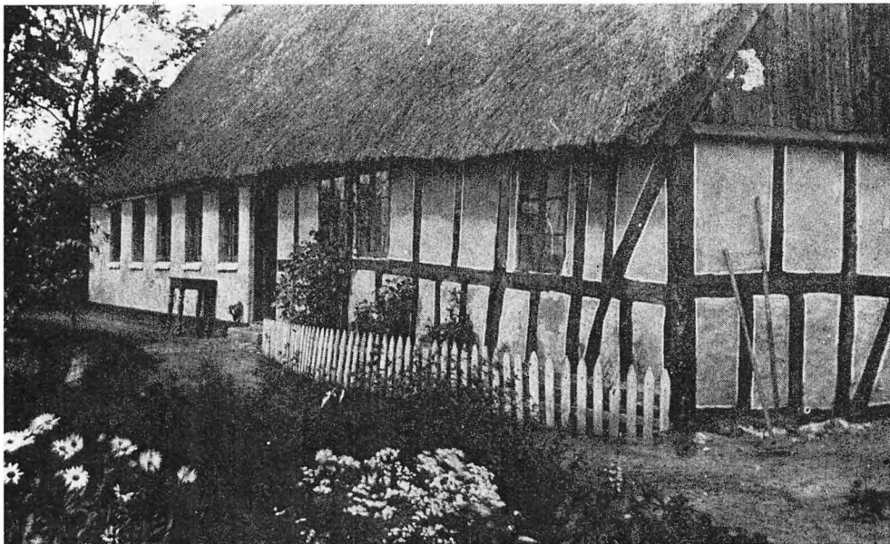
Daglejerhuset ved Tousgård, hvor forfatterens forældre boede fra 1907 til 1924. Oprindeligt var det et husmandssted med nogle tønder land. Da det blev købt af Tousgårds ejer, blev udhuset revet ned og det gamle stuehus forlænget med den fjerneste grundmurede del.
