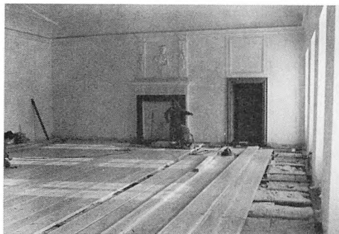
Ny gulvbelægning i Kongesalen.
