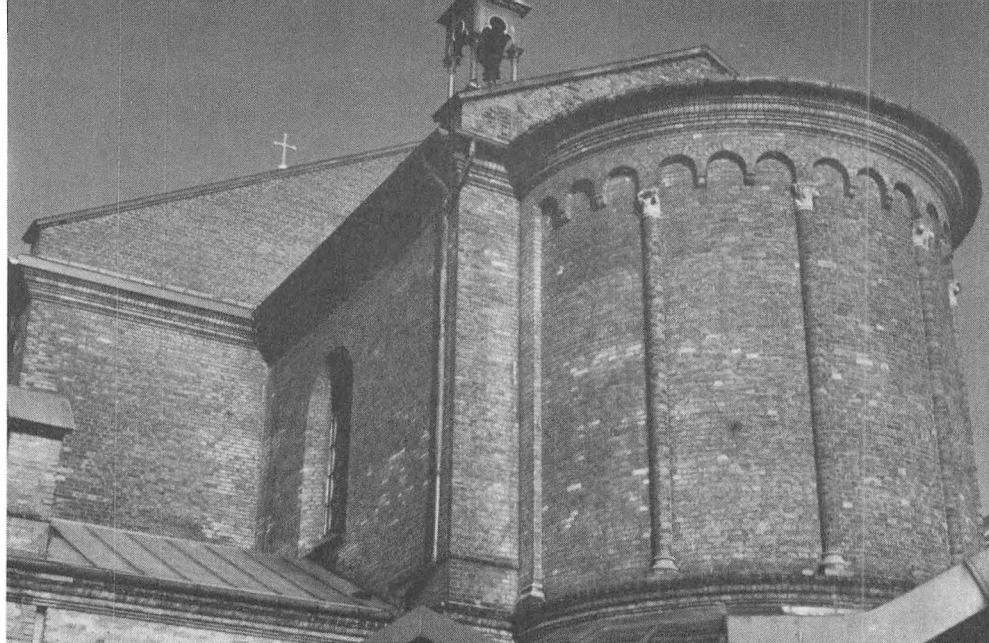
Pilastrene på Skt. Pauls kirkens apsis er udsmykket med omhyggeligt udført baser og kapitæler. (Foto: Forfatteren).
