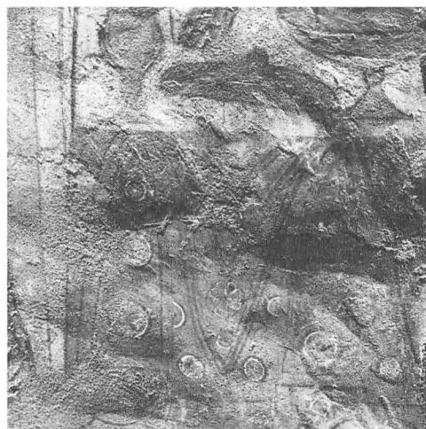
Mårslet kirke: Vestfag. Detalje optaget med skråtfaldende lys, der viser en tydelig sammenpudsning i malepudsen.
