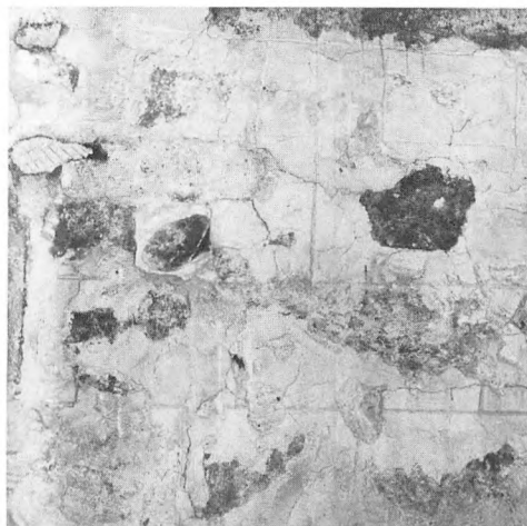
Mårslet kirke: Detalje af bygningsmørtlen i vestfaget. Maleren har forhugget bygningsmørtlen for at få et bedre forbandt til malepudsen. Under en aflang overligger til venstre i billedet ses det kvadratiske bomhul, hvori der er indmuret en sten med mørtel svarende til malepudsen.
