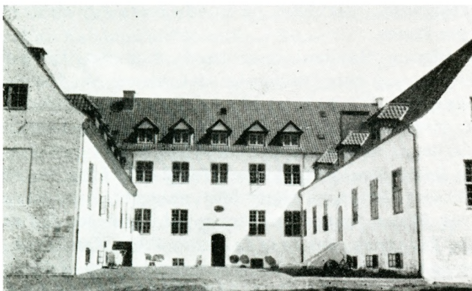
Kærgaard, set fra Vest. Kvistene i Taget er ny, ellers ser den ud, som da Fr. Gersdorf ombyggede den. Den er fornylig istandsat. Bemærk Hundehuset under Trappen. (Fra Ribe Amt).
