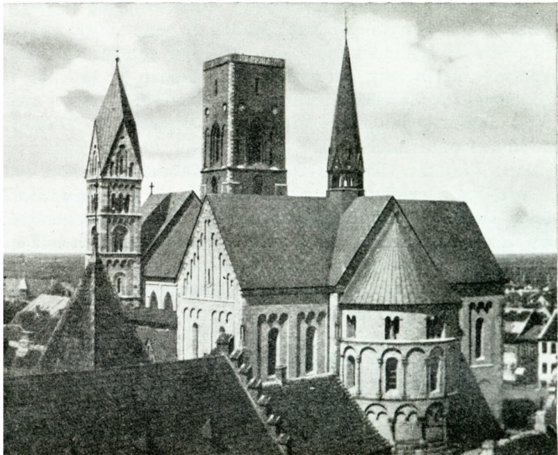
Ribe Domkirke udvendig, set fra Øst Vi ser Korrundingen (Apsis) og Tværfløjen og Marietaarnet af Tuf med runde Buer, Tagrytteren og Stormklokketaarnet med spidse Buer.
