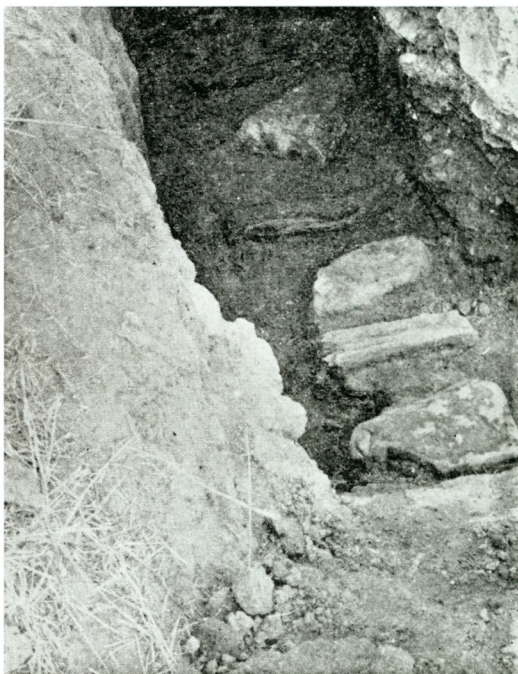
Fundament til Vardehus, afdækket i Borgbanken. (Fra Ribe Amt).
