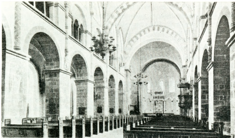
Ribe Domkirke indvendig. Over Buerne mellem de svære firkan- tede Sojler ses Triforierne, derover de senere tilbyggede spids- buede Vinduer.
