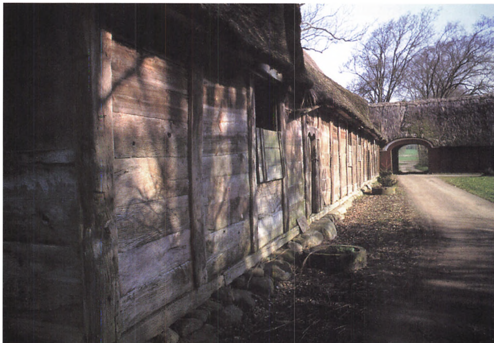
Helt op i 1700-tallet blev der bygget bulhuse i de skovrige egne mellem Haderslev og Kolding. Her er det bulladen ved Tyrstrup præstegård, opført kort efter 1658.
