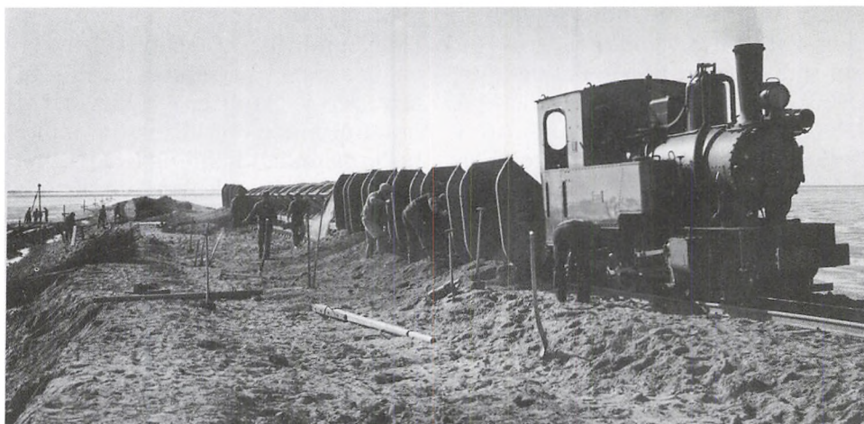
Arbejdet med bygningen af Rømødæmningen gav beskæftigelse til gennemsnitligt 400 arbejdere årligt i perioden 1940-48.
