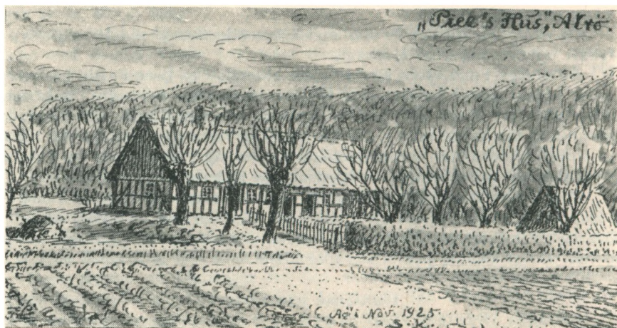
Bindingsværkshus ved Alrø Skov, kaldet Pies Hus.
