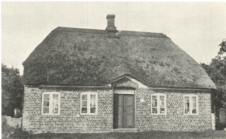
Jordemoderboligen i Skærbæk, der før Genforeningen var tysk kommunal Ejendom og siden da har været Tønder Amts Ejendom.
