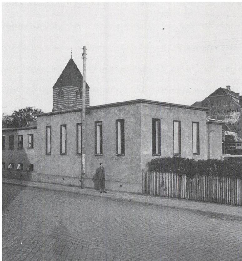
Stege automatcentral 1941, facaden. (Foto: Dansk Post- og Telegrafmuseum).
