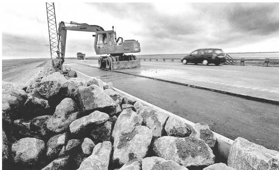
Efter lang tids diskussion mellem Staten og Sønderjyllands amt om finansieringen af reparationer af Rømdæmningen var gravkøer ved at gøre de sidste arbejder på dæmningen færdige. Foto: Hans Christian Gabelgaard. JydskeVestkysten.
