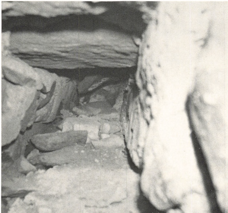
Fig. 2. Det 190 cm lange bombul. Bemærk rester af mørtel i højre side, hvor op imod forskalningen har stået. Foto: forfatteren.
