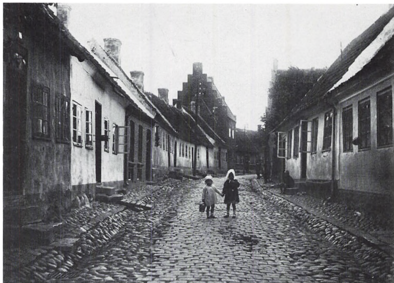
Fig. 2. Præstegade. I midten til venstre ses den østre del af den gamle præstegård. Det høje, murede hus er den middelalderlige del, nu Præstegade 23. På gavlen anes spor af den oprindelig to etager høje bindingsværksbyggede østre længe. Nationalmuseet fot. ca. 1920.
