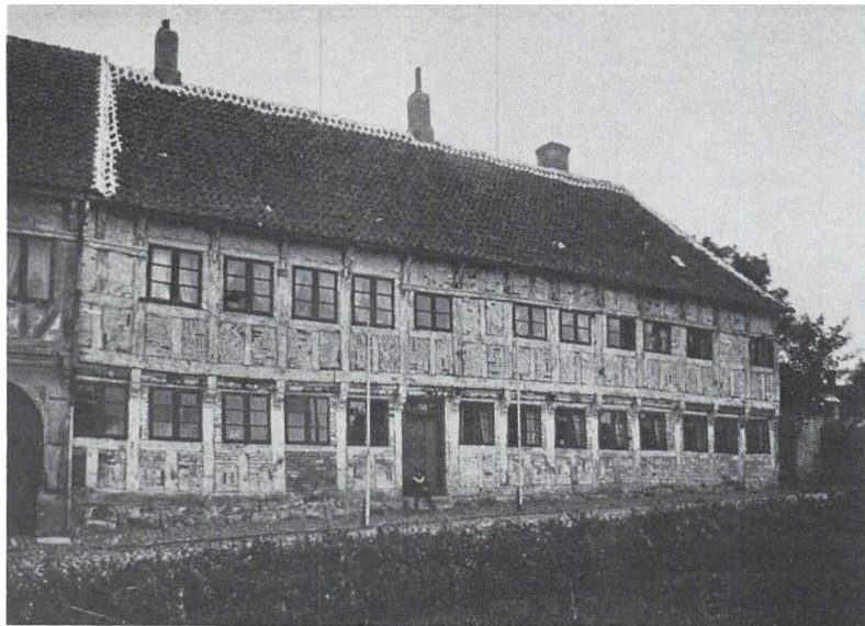
Fig. 1. Adelgade 19. Facaden er rensat for puds og kalk i forbindelse med C. M. Smidts restaurering. I dag står huset med sorttjæret tømmer og tavl af ubehandlede teglsten. C. M. Smidt fot. 1906. Byhist. arkiv, Kalundborg.
