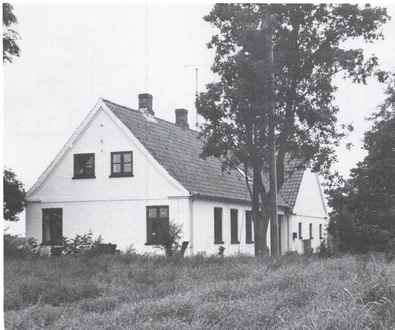
Bygningerne til de statshusmandbrug, der udstykkedes i 1920'erne, ligner næsten alle dette brug ved Løvenborg allé. Mange af de standardtegninger, som staten stillede til rådighed, blev udført af Holbæk-arkitekten Marius Pedersen. DHC foto.
