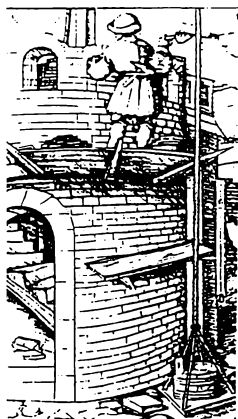
Murer i arbejde på stillads. Efter Hans Schäußelein 1517.
