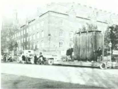
Transformator, Vægt 35 Tons.
