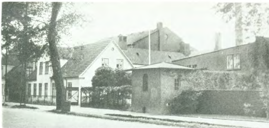
A/S H. P. Løvingreen's Garveri, Roskildevej 57.
