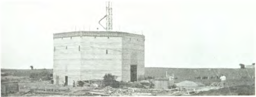
Rudolph Tegnens Museum under Opførelse 1937.
