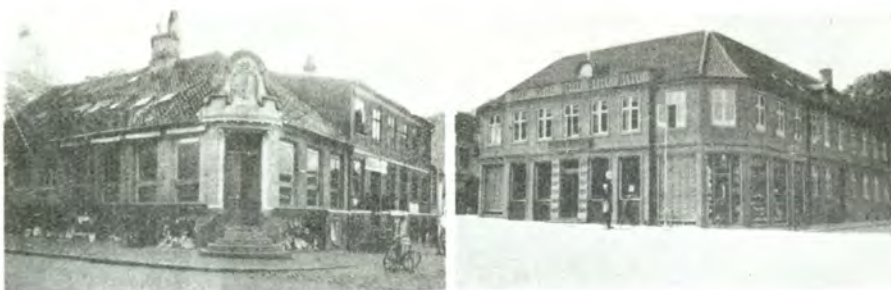
Landbobanken i Slagelse før og efter Ombygningen.
