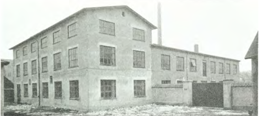
Københavns Glasværk, Saltværksvej 19.
