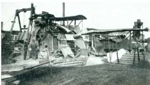
Asfaltbetonmaskinen i Arbejde.
