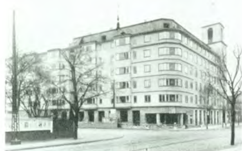
Vagtselskabet og Ungkarlehuset, isoleret med Arki-Maatter.
