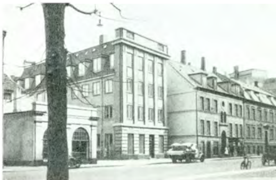
A/S Arbo-Bähr & Co.s Administrationsbygning.
