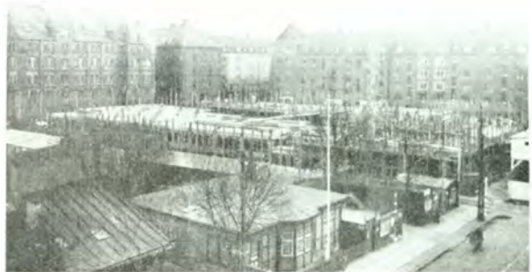
Kontor og Lagerbygning for F. D. B., Njalsgade.
