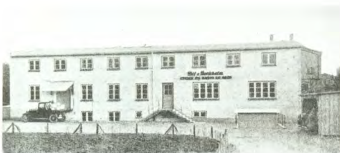
Sdr. Stationsvej 41. Opført 1936.
