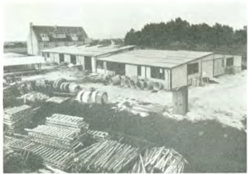
Cementstøberiet paa Kettevej.
