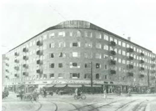
Hjørnet af Rosenørns Allé og Aaboulevard, isoleret med Arki-Maatter.
