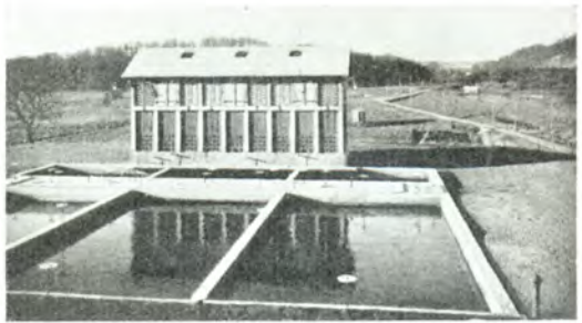
Filteranlæg i Elbodalen.
