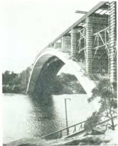
Transebergbroen, Stockholm, elektr. svejst med Kjellberg-Elektroder.
