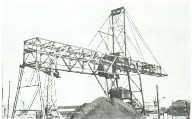
Plads-Kran for Losning.
