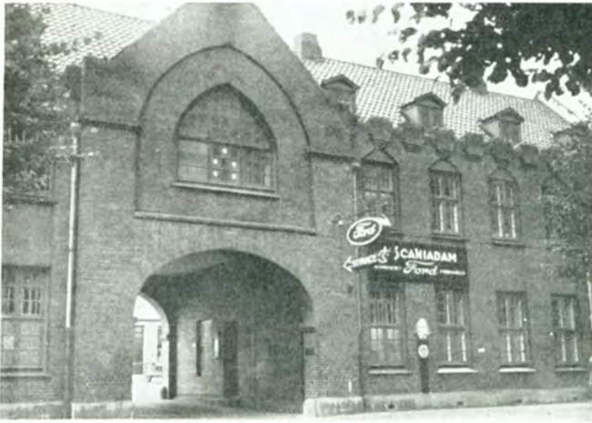
A/S Scaniadam, Lyøvej 20. Facaden.
