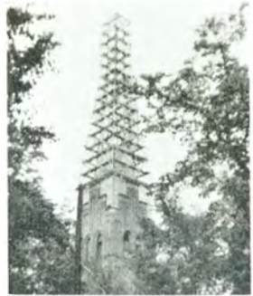
Stilladsarbejde ved Sct. Johannes Kirkens Spir.
