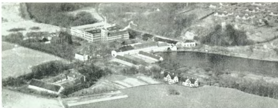
Brede Klædefabrik med Arbejderboliger.
