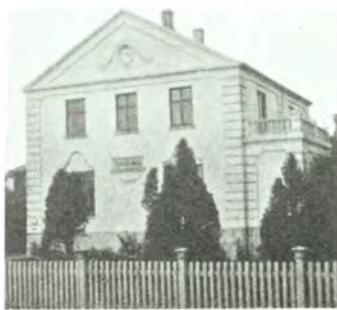
Raadhuset i Frederiksværk.
