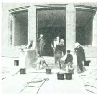
Asfaltbelægning over Tunnel, Bispebjerg Hospital.
