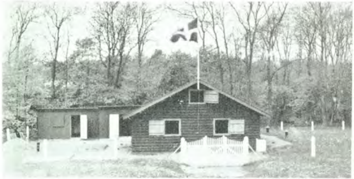
Allinge-Sandvig Gas- og Vandværk (opført 1911). Iltnings- og Filteranlæg.
