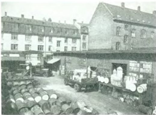
Erik Berg, Nordre Fasanvej 228.
