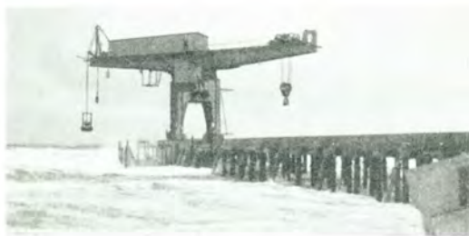
Bygning af Dækmoles ved Havnstholm med 100 t. Titankran.
