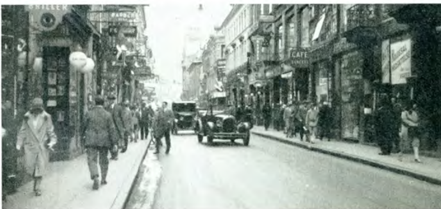
Frederiksbjerggade belagt med Hadsphalt.
