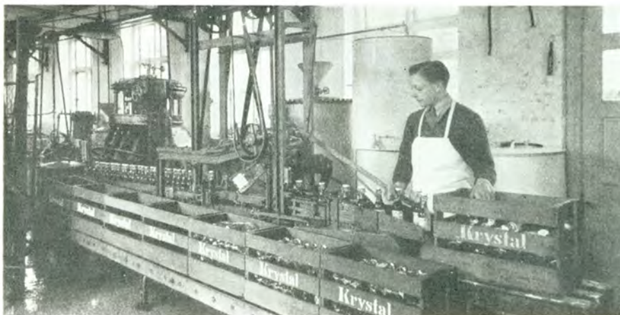
Flaskerne passerer Etikettmaskinen.
