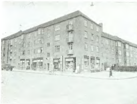
Aalekistevej og Bøgholder Allé.
