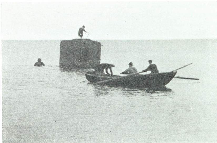
Dykker Th. Nielsen staar paa Skroget og Cl. Sørensen paa Kommandotaarnet. Sammenknytning af 10 elektriske Ledninger fra Minerne til Hovedledningen.
