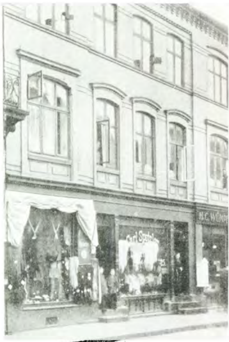
Kongensgade Nr. 25, der blev nedrevet i 1929.
