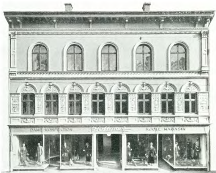
Facade af Ejendommen Kongensgade Nr. 29.
