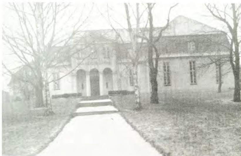
Odd Fellow Ordenens Bygning.
