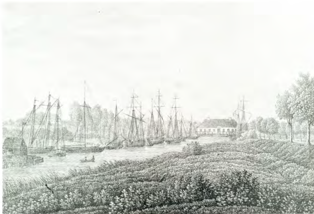
Kanalbassinet ved Odense i ældre Tid.
