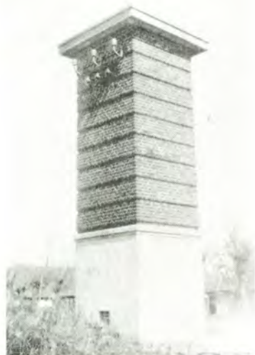
Transformatorstation udført af Firmaet Brdr. Henriksen.
