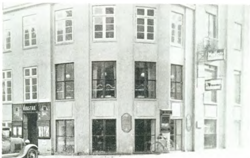
Hjørnet af Graabrødreplads og Jernbanegade med „Den gamle Vinstue“.
