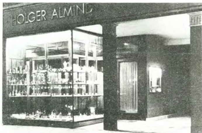
Facaden til Guldsmed Alminds Forretning.
