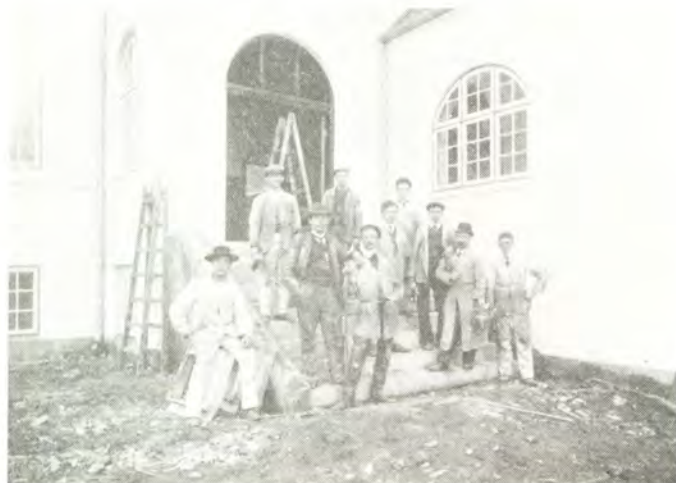
Fra Malerarbejdet paa Tarup Husmandsskole.
