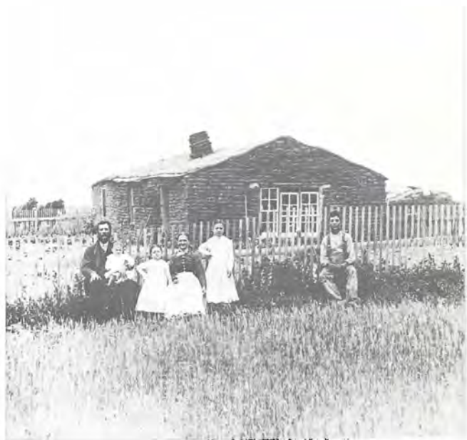
Jordhuset, the 'sod-house', bygget helt af tørv, var den almindelige hustype på den træfattige prærie. 1890.
