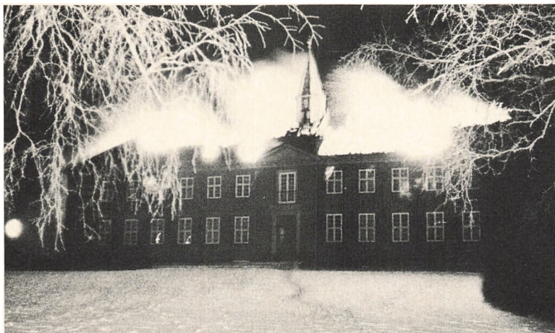
Branden på hovedbygningen.
