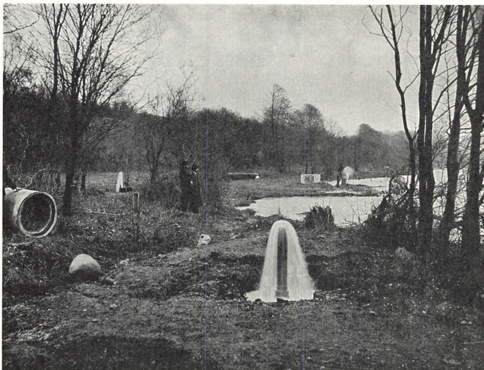
Boringer ved Søndersø.
