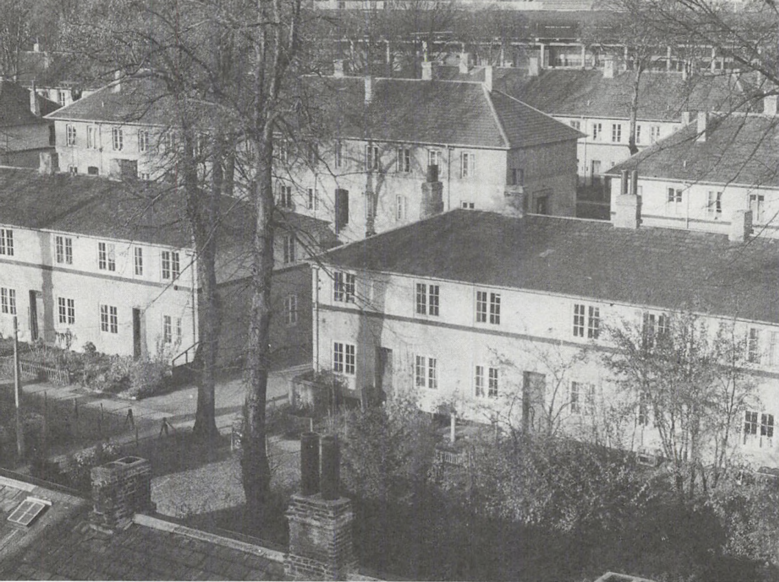
Brumleby set fra Olufsvvej. Forrest Bindsbøll-blokkene. I midten den højere blok N med Købmanden i gavlen. Fotografi 1975.
