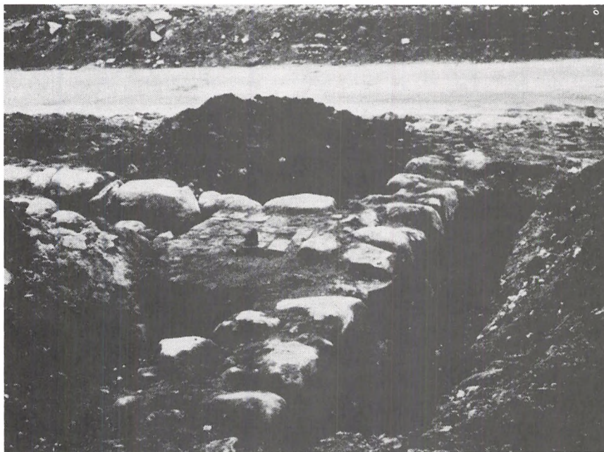
Billedet viser det solide fundament. Foto: Henrik Jørgensen.
