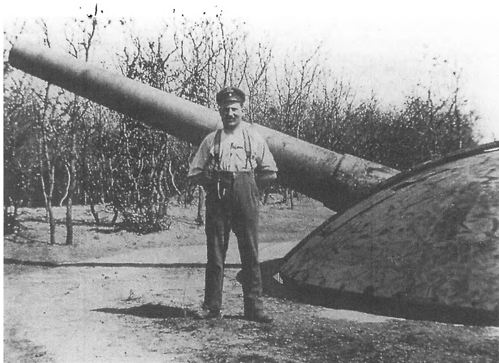
En 24 cm afmonteret tysk slagskibskanon ved batteriet Gammelskov nær Agerskov, et led i det stærke fæstningsværk Sicherungsstellung Nord. Foto: Mogens Scott Hansen.
