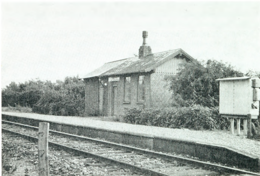
Billetsalgssted til 1923 - - - trinbræt fra 1962
