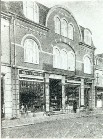
Jens Clausens Isenkramforretning.
