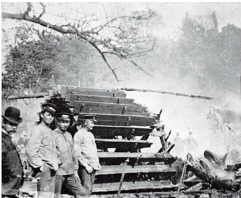
Lyngby søndre mølle efter branden i juli 1902. I forgrunden ses det delvis ødelagte underfaldshjul. I de rygende ruiner skimtes møllesten og forkullede bjælker. Året efter blev møllen genopført i sin nuværende skikkelse. Collins samling.
