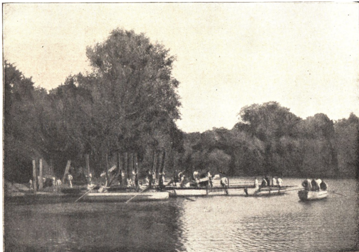
Broslagning over Kastelsgraven ved Østre Glacis.
