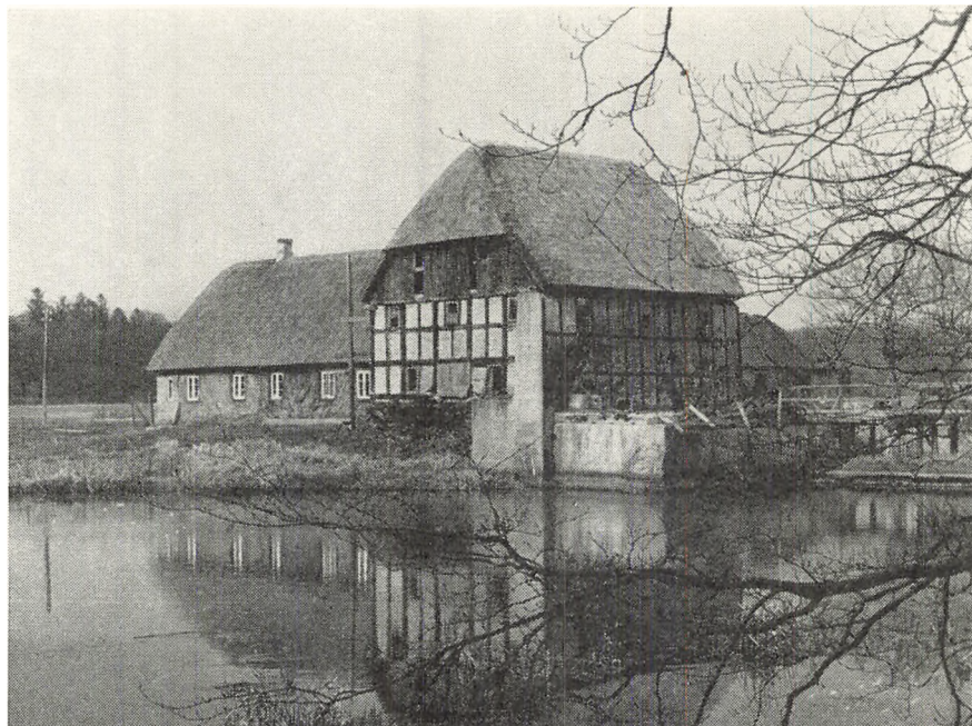
Nørholm Vandmølle ved Varde. Møllen er ude af drift, men skal istandsættes. Den havde i sine velmagtsdage to store underfaldshjul, hvilket endnu kan spores på møllehuset. Det var en af de største møller i Vestjylland. A. Jespersen fot.
