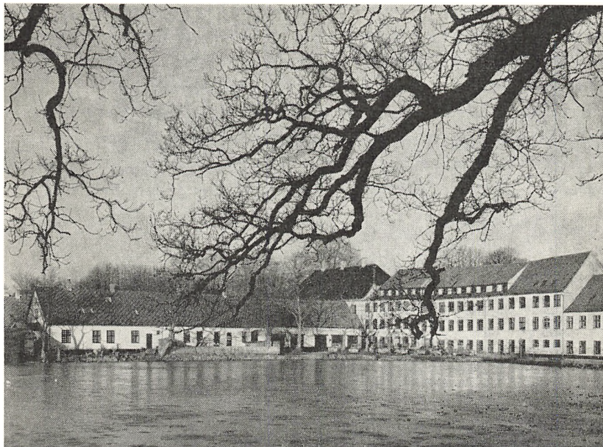
„Mesterlængen“ og de gamle fabriksbygninger i Brede, set fra sydøst. Lennart Larsen fot. 1959. Nationalmuseet.
