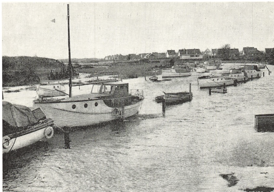
Varde Havn under oversvømmelse. Til venstre den borgbanke, hvorpå Vardehus stod.
