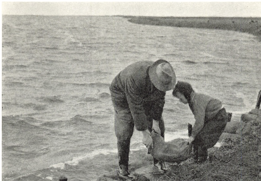
Højvande i Vidåen. Et udsat punkt sikres med sandsække. Gabs-Tønder fot.
