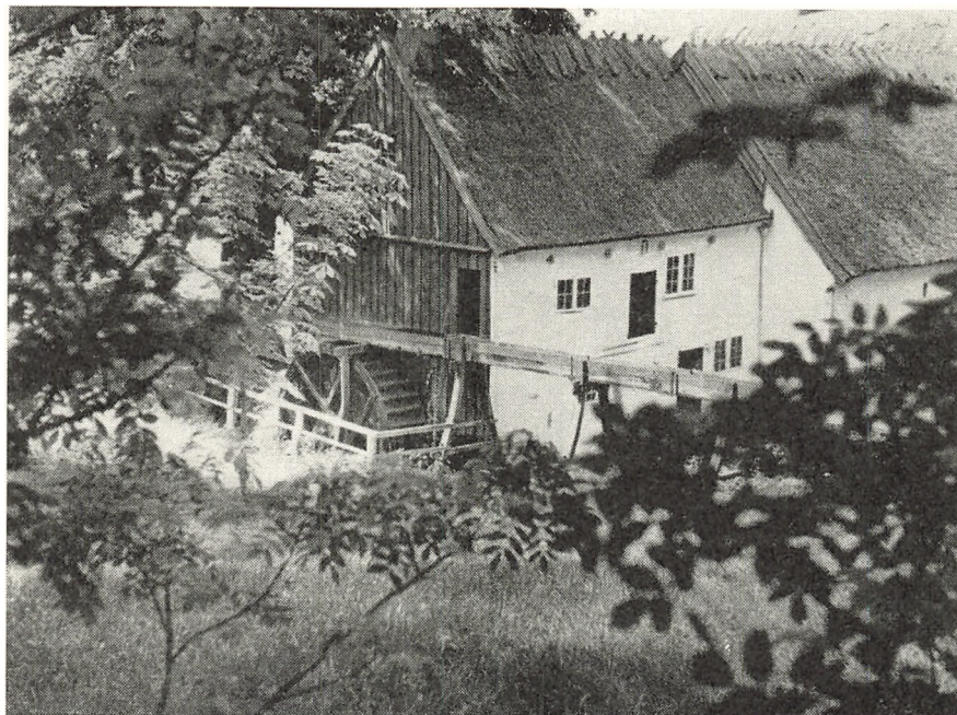
Tadre Mølle ved Tølløse. Møllen er sat i stand og bruges stadig. Åen er opstemmet i en langstrakt sø langs dalsiden, og herfra ledes vandet gennem trærenden til overfaldshjulet. A. Jespersen fot.
