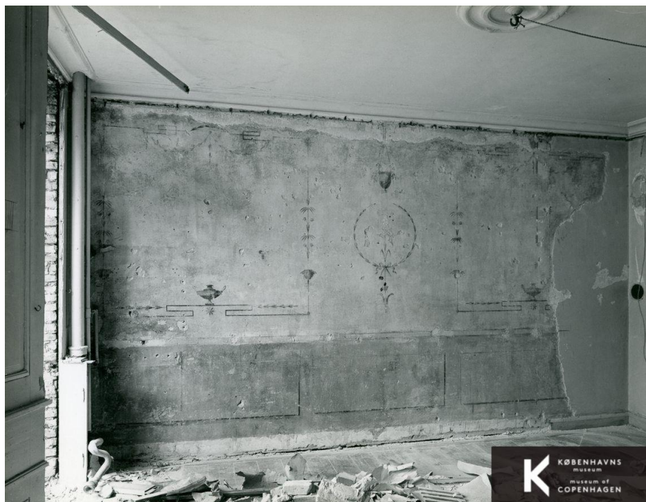
Admiralsgade 31 Del af vægdekoration. Bygning nedrevet ca.1956.
