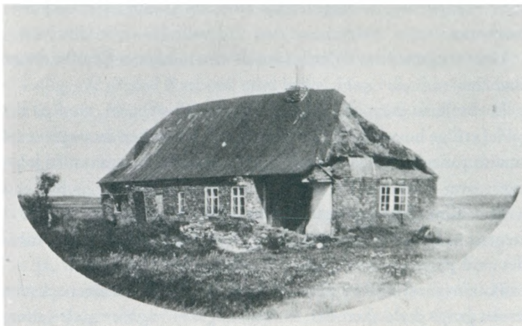
Mit hus er næsten faldet. Skorstenen er blevet udbedret, men det begynder at skride ud i begge ender. Det skred dog meget mere sammen, inden han forlod det. Foto lånt af Marie Jørgensen, Nr. Bork
